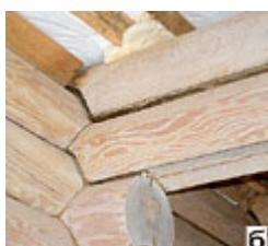
Даже выгиб стен наружу не позволил кровельной конструкции сесть на место. По-видимому, стропила все-таки оторвались от конькового бруса. Об этом свидетельствует широкая щель (а), образовавшаяся между бревнами, составляющими сдвоенную опорную балку, - "подвинулось" лишившееся нагрузки верхнее бревно (б)
