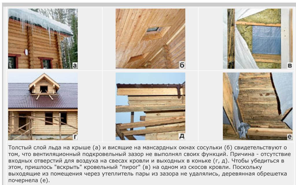
Толстый слой льда на крыше (а) и висящие на мансардных окнах сосульки (б) свидетельствуют о том, что вентиляционный подкровельный зазор не выполнял своих функций. Причина - отсутствие входных отверстий для воздуха на свесах кровли и выходных в коньке (г, д). Чтобы убедиться в этом, пришлось "вскрыть" кровельный "пирог" (в) на одном из скосов кровли. Поскольку выходящие из помещения через утеплитель пары из зазора не удалялись, деревянная обрешетка покернела (е).
