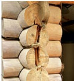
Удерживать внутренние стены от разборки на составные части должны не только нагели, но и так называемые обсадные бруски. Их вставляют в вертикальный паз, который прорезан в торцах бревен, выходящих в дверные проемы. Как видите, здесь эти элементы либо отсутствуют, либо установлены в отдельных местах
