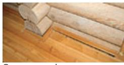
О том, что фасадные стены выгнулись наружу, свидетельствует широкая щель между плинтусом и чистовым настилом пола второго этажа (величина подвижки больше ширины плинтуса)
