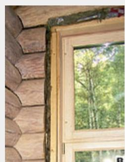
Такая установка окон ничего общего с ГОСТ 30971-2002, регламентирующим этот вопрос, не имеет. Какие там трехслойные конструкции из наружной водопароизоляции, пенного утеплителя и внутренней пароизоляции! Оконные коробки перерублены (а), зазоры заложены досками (б) и заткнуты паклей (в). Мало того, в них еще и электрокабель разместили.
